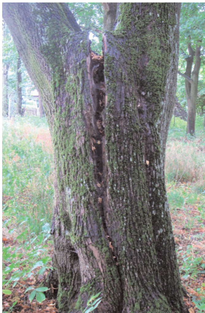
Zakorek (wada budowy drzewa) spowodował pęknięcie pnia u nasady korony i w krótkim czasie spowoduje jego rozłamanie
