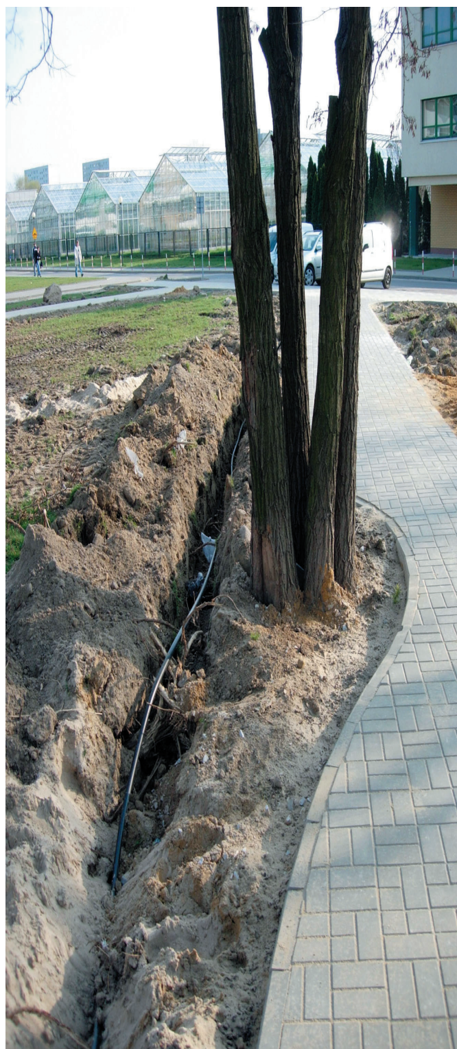
Fot. 3. Położenie nowego chodnika po jednej stronie pnia drzewa oraz wykop pod instalację po drugiej spowodowały obcięcie większości korzeni. Drzewo skazane jest na zamieranie. Poprowadzenie chodnika i instalacji po tej samej stronie ocaliłoby ponad 50% systemu korzeniowego
